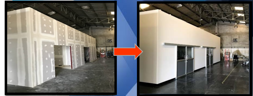
กั้นห้องด้วยแผ่นยิปซัม พร้อมทาสี
